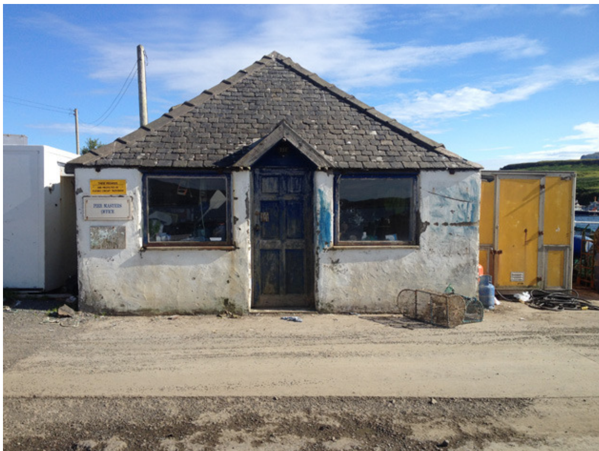
Hamnkontoret i Dunwegan ser dig.
